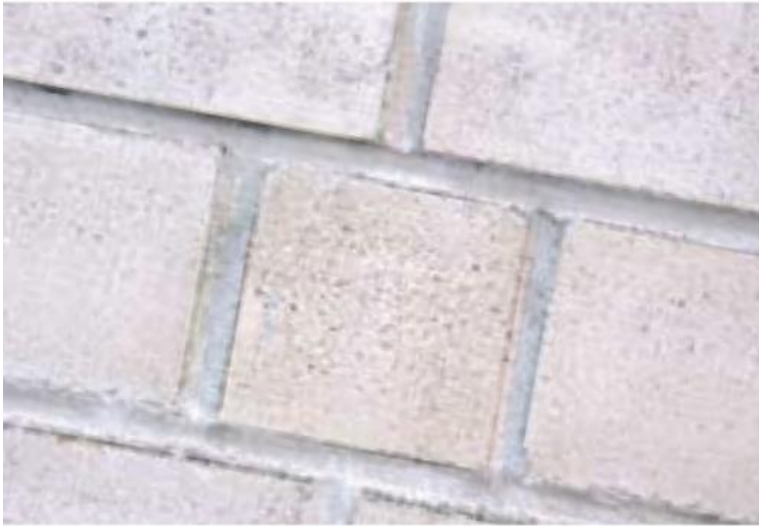
Gevel behandeld met Guardon® StayClean+Protect Mineral Pro, na 24 maanden
