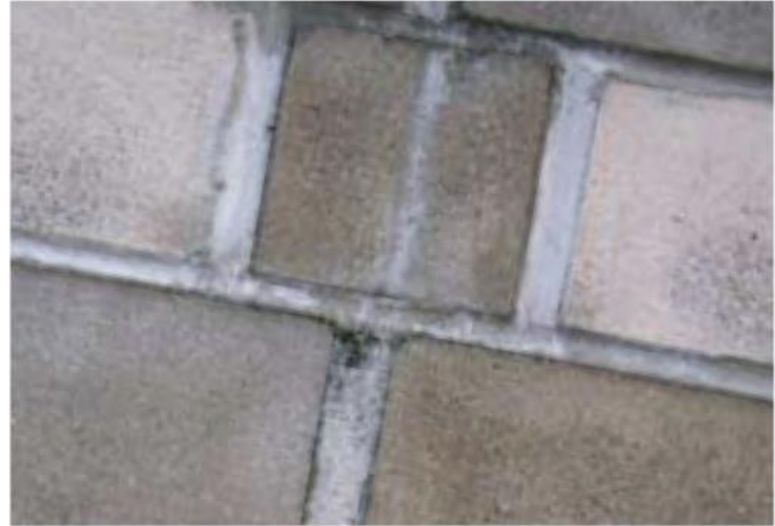
Gevel onbehandeld, na 24 maanden
